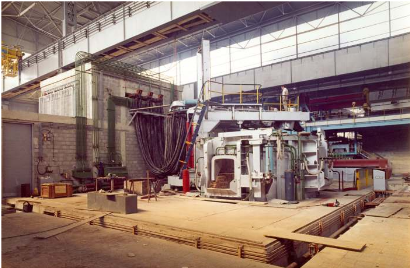
Na fotografiji: montaža prve elektrooblo ne pe i v Štorah
