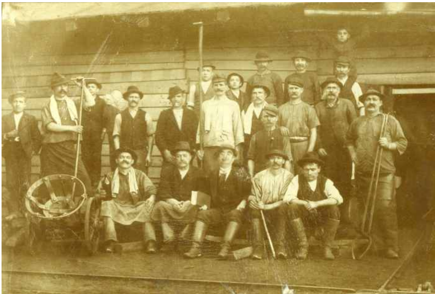
Skupina pudlarjev z orodjem, ki so ga uporabljali, in vozi kom za prevoz žare ega volka (kepe pudlanega jekla), od pudlovke do kovaških kladiv, kjer se pripravi za valjanje; 1905, fotografija, hrani Železarski muzej Štore
